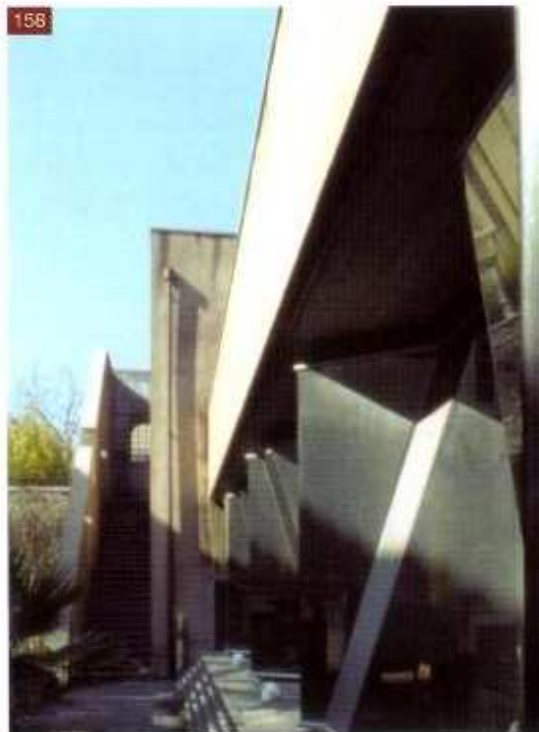
158. Centrale termica, scorcio della parete vetrata
