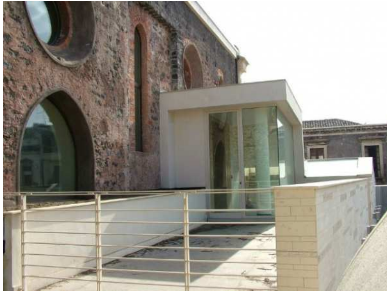
Chiesa dei Santi Giorgio e Dionigi a Catania, progetto vincitore della sezione recupero o riconversione di architetture esistenti
